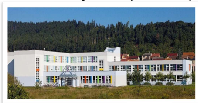
Obrázek č. 55: Fotografie budovy základní školy
