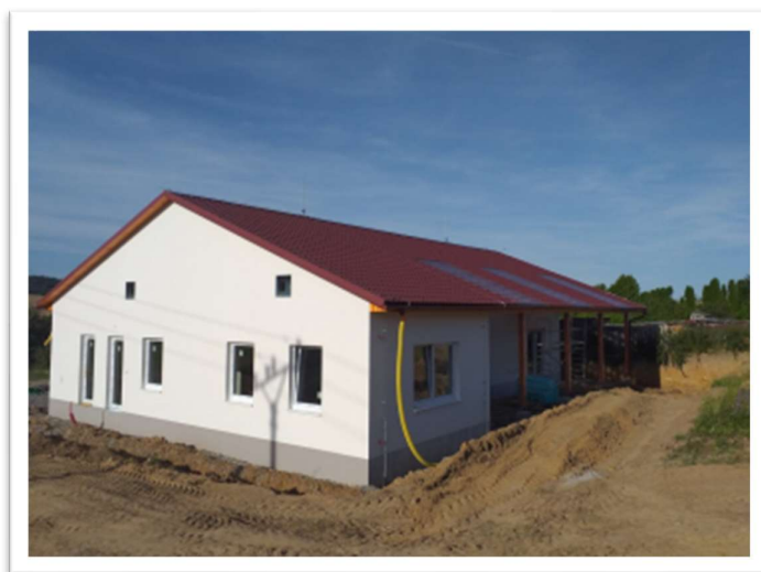
Obrázek č. 68: Fotografie budovy základní školy
