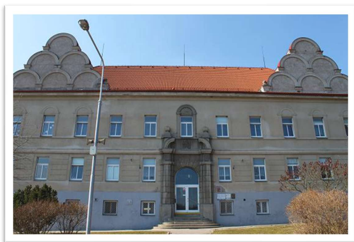
Obrázek č. 65: Fotografie budovy základní školy
