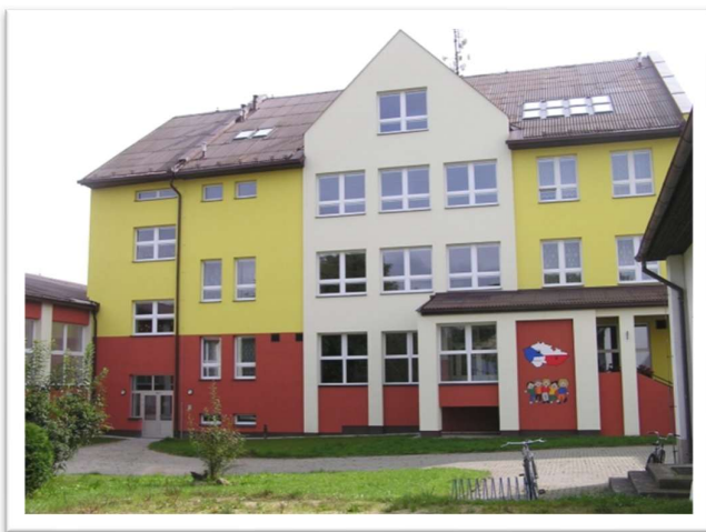
Obrázek č. 64: Fotografie budovy základní školy
