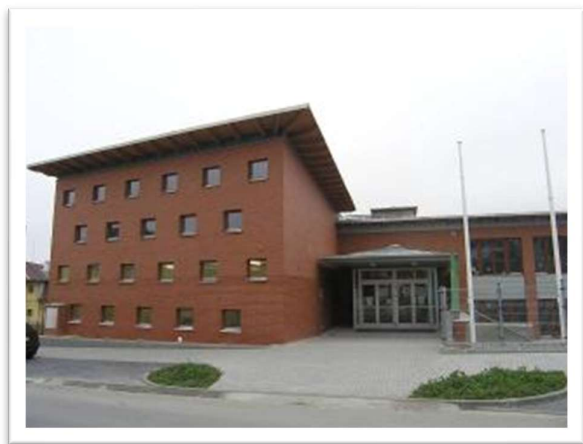
Obrázek č. 56: Fotografie budovy základní školy
