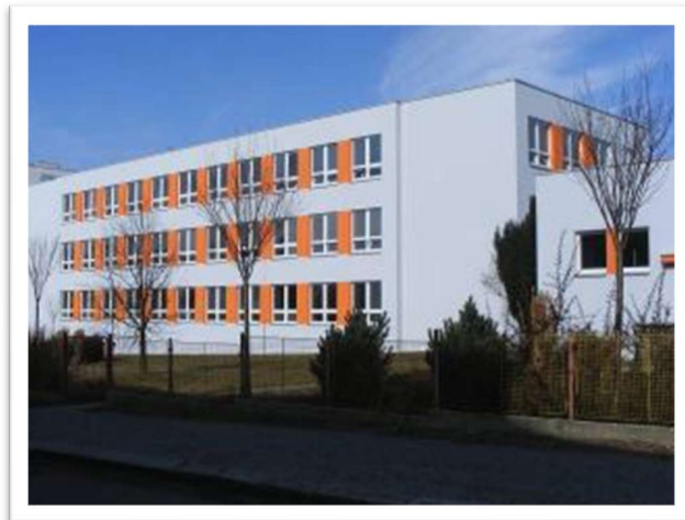
Obrázek č. 54: Fotografie budovy základní školy
