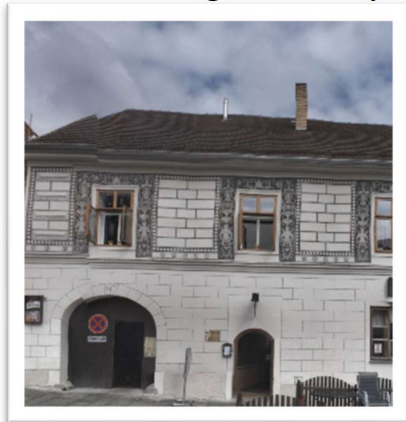
Obrázek č. 66: Fotografie budovy základní školy
