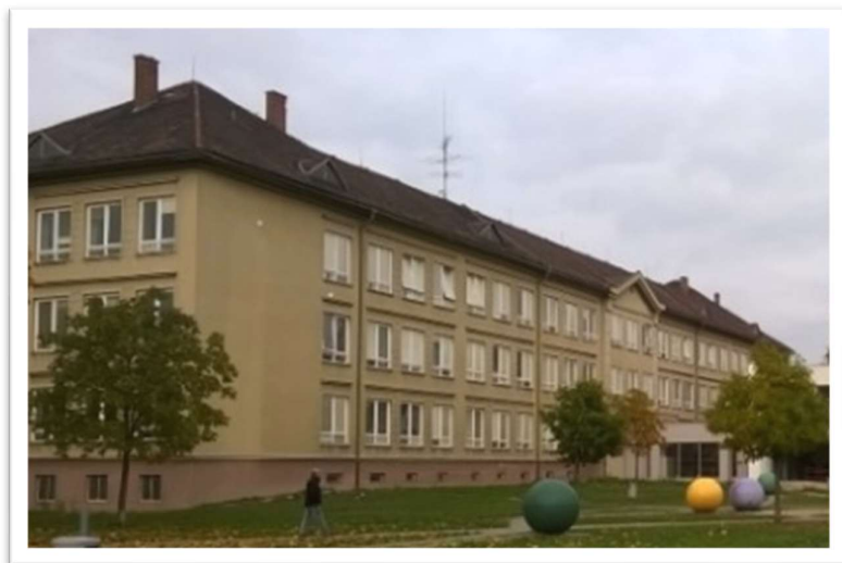
Obrázek č. 53: Fotografie budovy základní školy
