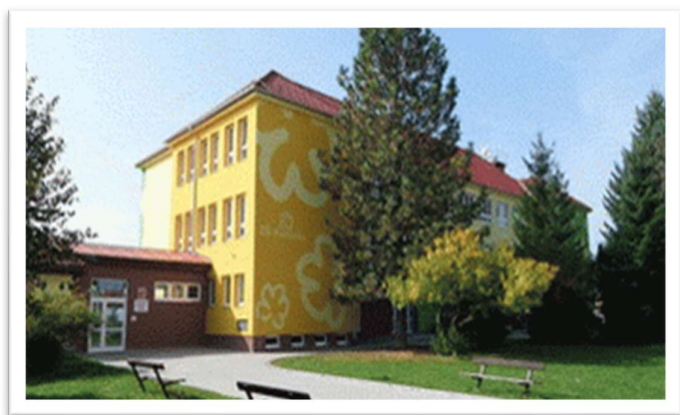
Obrázek č. 60: Fotografie budovy základní školy
