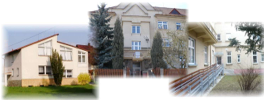
Obrázek č. 63: Fotografie budovy základní školy
