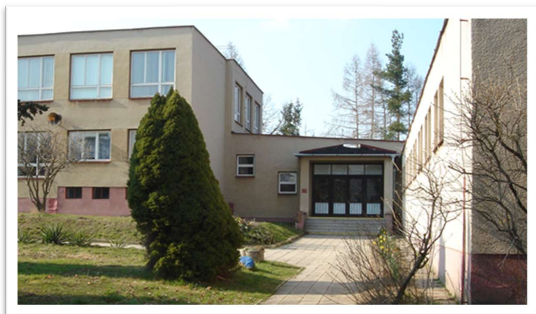
Obrázek č. 59: Fotografie budovy základní školy
