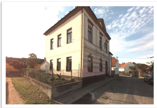
Obrázek č. 69: Fotografie budovy základní školy
