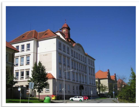
Obrázek č. 57: Fotografie budovy základní školy
