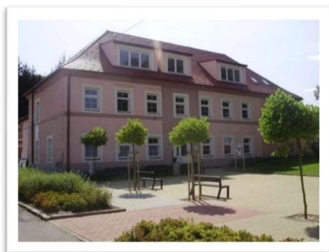
Obrázek č. 61: Fotografie budovy základní školy
